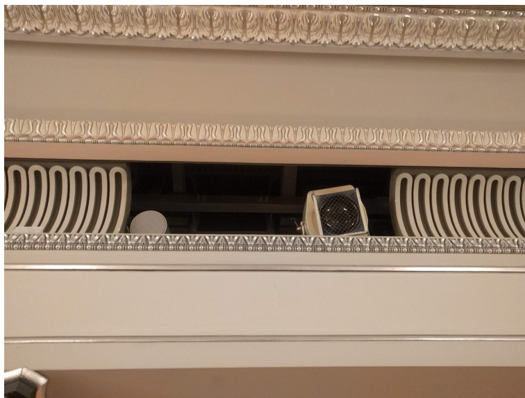
Figura 5: CR3, dettaglio del perimetro del soffitto (foto del dataset BRAS, Pictures/Details/5_ceiling_detail_1.jpg). Il soffitto è chiuso e decorato, ma sul perimetro corre una griglia di aerazione a lamelle : attraverso l'apertura si vedono le travi strutturali, un faretto e una bocchetta di ventilazione dentro il volume sopra il soffitto. È la «small connection on the ceiling» del commento BRAS; la connessione dominante è al palco.
